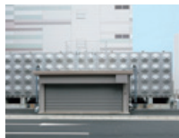
大容量の受水槽(600トン)
