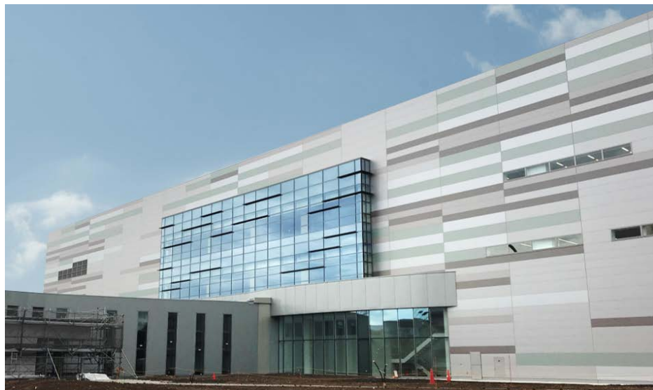
検査ラボ棟（撮影日：2020年9月10日）
