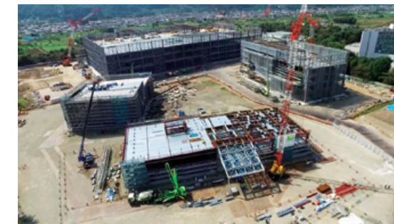
建設中の新セントラルラボラトリー
