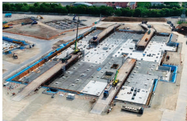
建設工事の様子
